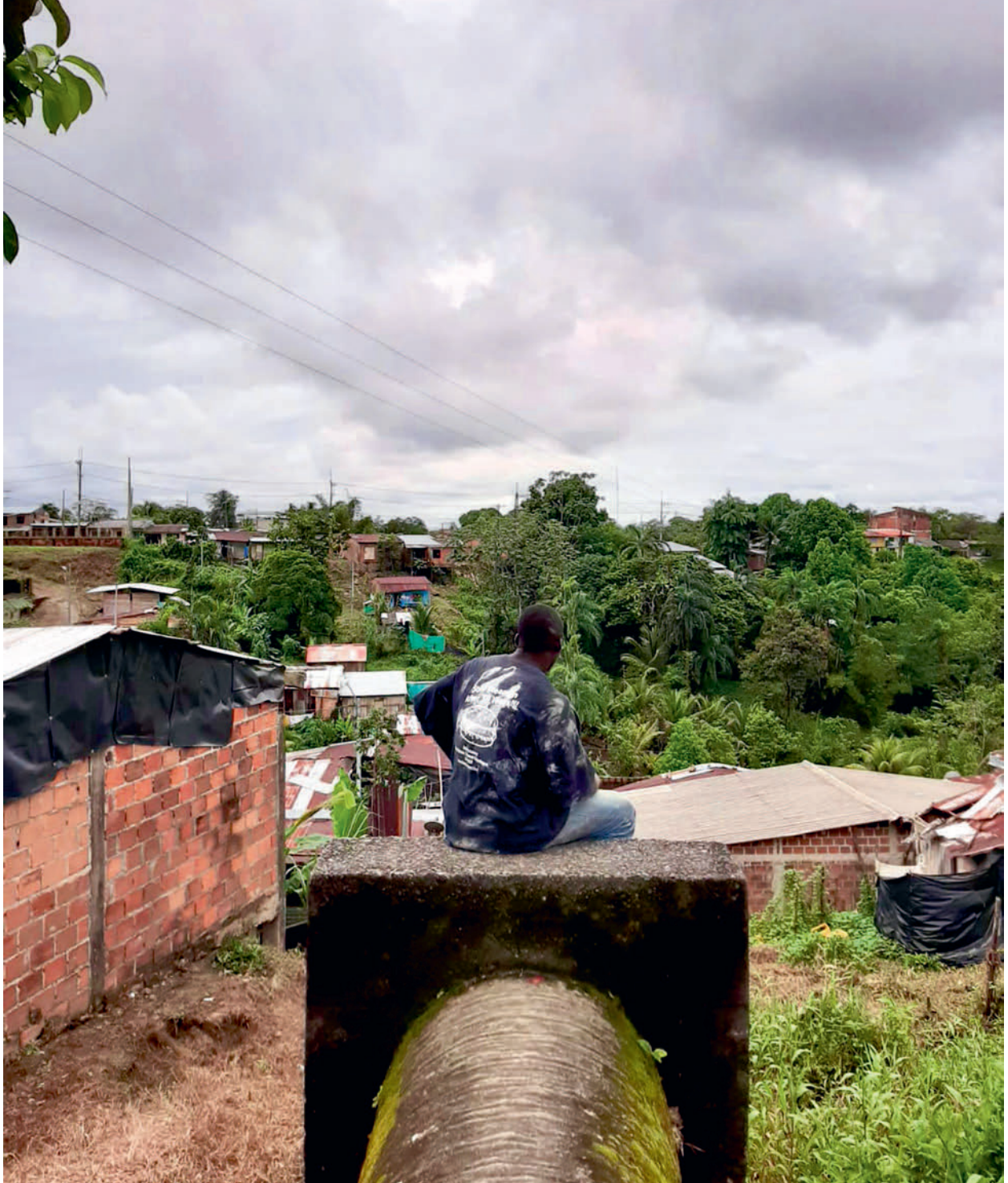
3 Wasserleitung in Ciudad Blanca
